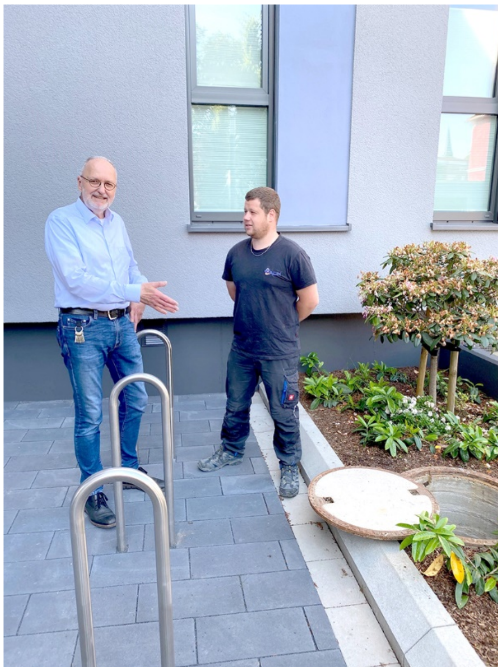
Bild 5: Wolfgang Pollmeier, Geschäftsführer der Plangruppe-Bau GmbH & Co. KG (links) und Benjamin Sieks, Bauleiter des ausführenden Installationsunternehmens ADK Kälte-Klima-Heizung-Sanitär GmbH & Co. KG, beide aus Herford, sind mit der Pumpentechnik von Jung Pumpen zufrieden.
