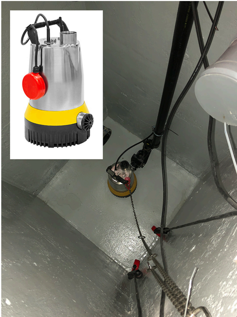
Bild 2: MultiDrain UV 600 Tauchpumpen fördern Schmutzwasser aus großen Tiefen
