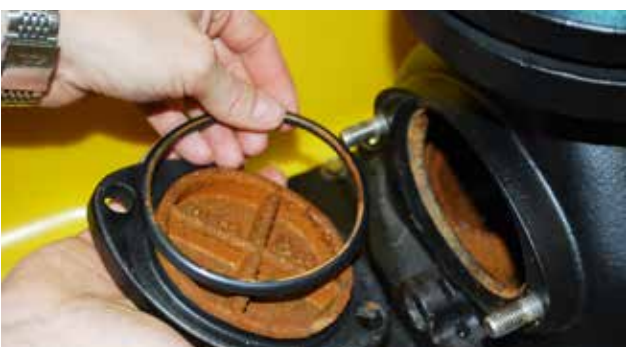
▶ Kontrola i czyszczenie kłapy zwrotnej
