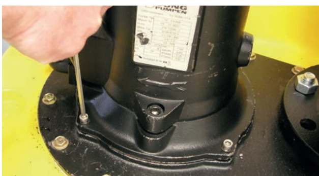
▶ Eenvoudige demontage van de pompeenheid
