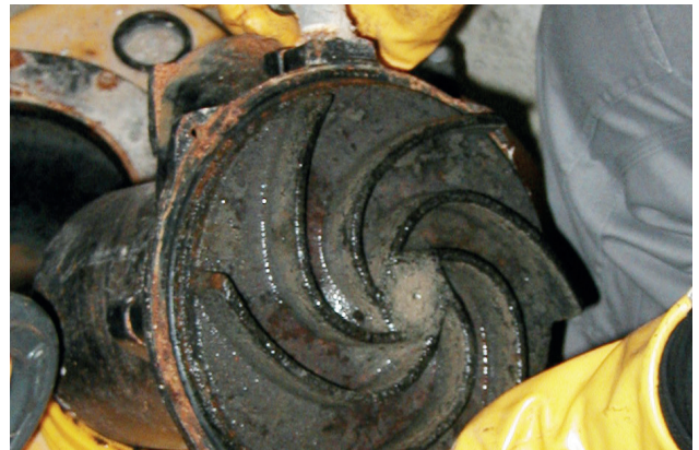
▶ Checking the impeller
