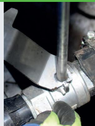
► Installation Kugelhahngriff
