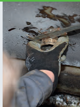
► Kürzen des Druckabgangs im Schacht
